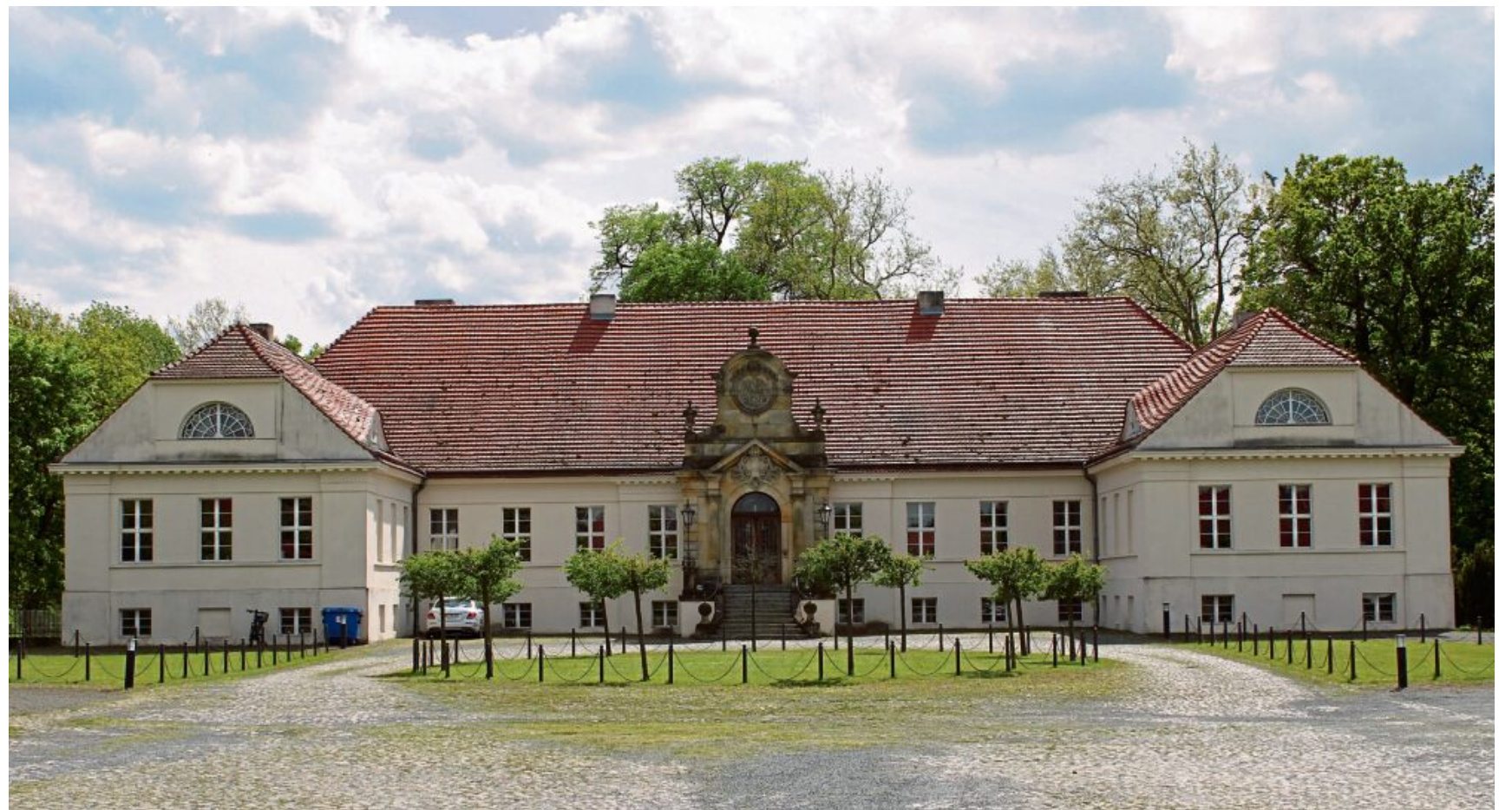
Das Schloss Diedersdorf in Seelow wurde im 18. Jahrhundert im Stil eines Gutshauses errichtet.
